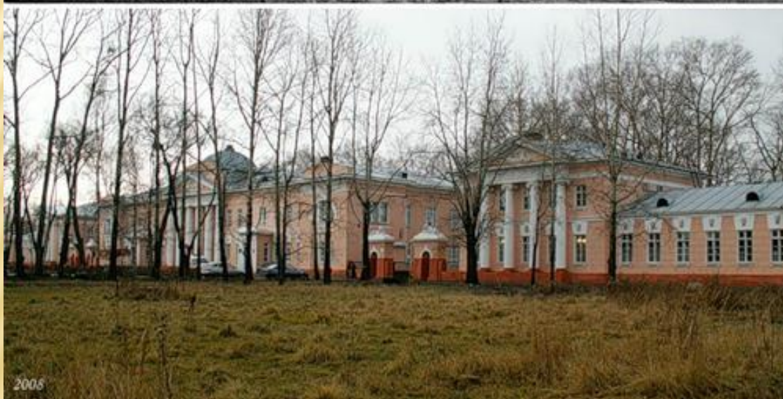
Фабричная больница села Бонячки (1912) — Центральная районная больница г. Вичуги (2008)
