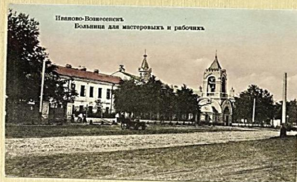
40. Больница для мастеровых и рабочих на Никольской улице (не сохранилась). Открыта в 1861 году в Вознесенском посаде на средства фабрикантов, на участке земли, пожертвованном Ф. П. Зубковым. Инженером строительства выступил Я. П. Гарелин. В 1866 году к главному корпусу пристроили богадельню с Никольской церковью и в 1873 году — Александровский детский приют. Больница обслуживала несколько тысяч рабочих.
